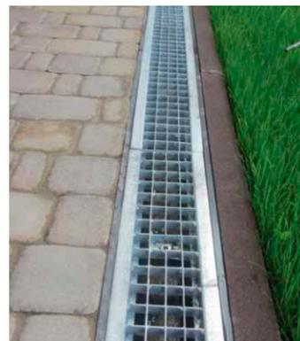
Решетка водоприемная ливневая из оцинкованной стали Basic DN100 предназначена для установки в зонах где нагрузка не превышает 3-х тонн с неинтенсивным трафиком для устройства ливневки типа поверхностного линейного водоотвода.
