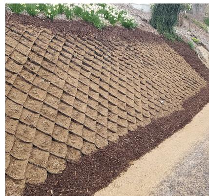
Георешетка TERRA 6000X2550 мм, Н=200 мм, ячейка 220x220 мм (26.0 кг/модуль, S=15,3м<sup>2</sup>) - используется для крупномасштабных проектов. Данная георешетка выдерживает экстремальные нагрузки и может использоваться на склонах крутизной до 45 градусов.
